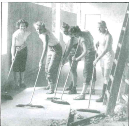
Katharina Popp stellte uns dieses Bild zur Verfügung. Die Schülerinnen fegen den Rohbau des damals neuen Schulgebäudes aus (etwa 1954). Bald wird es im Ensemble der Schulgebäude wieder ein „Neues Schulhaus“ geben!
