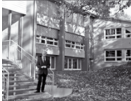
Die isolierten Wände, vor denen Bruder Schaible steht, sorgen für ein besseres Klima – und niedrigere Heizkostenrechnungen
