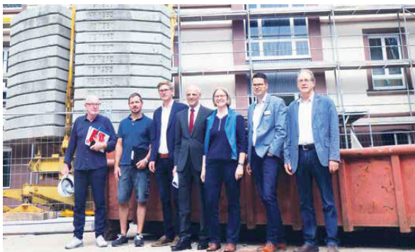
An der Baustelle (von links): Reiner Ketterer, Thomas Sohmer (Hausmeister), Michael Sauer, Fritz Link, Heike Lutz-Marek (stellv. Schulleiterin), Tobias Banholzer und Schulleiter Johannes Treude. Foto: mm
