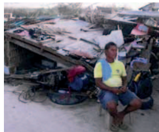
Das Haus in einem Fischerdorf auf der Insel Molocaboc Dako ist auf Hüfthöhe zusammengekracht. Darunter kauert die Familie und sucht Schutz, trotz Einsturzgefahr.
