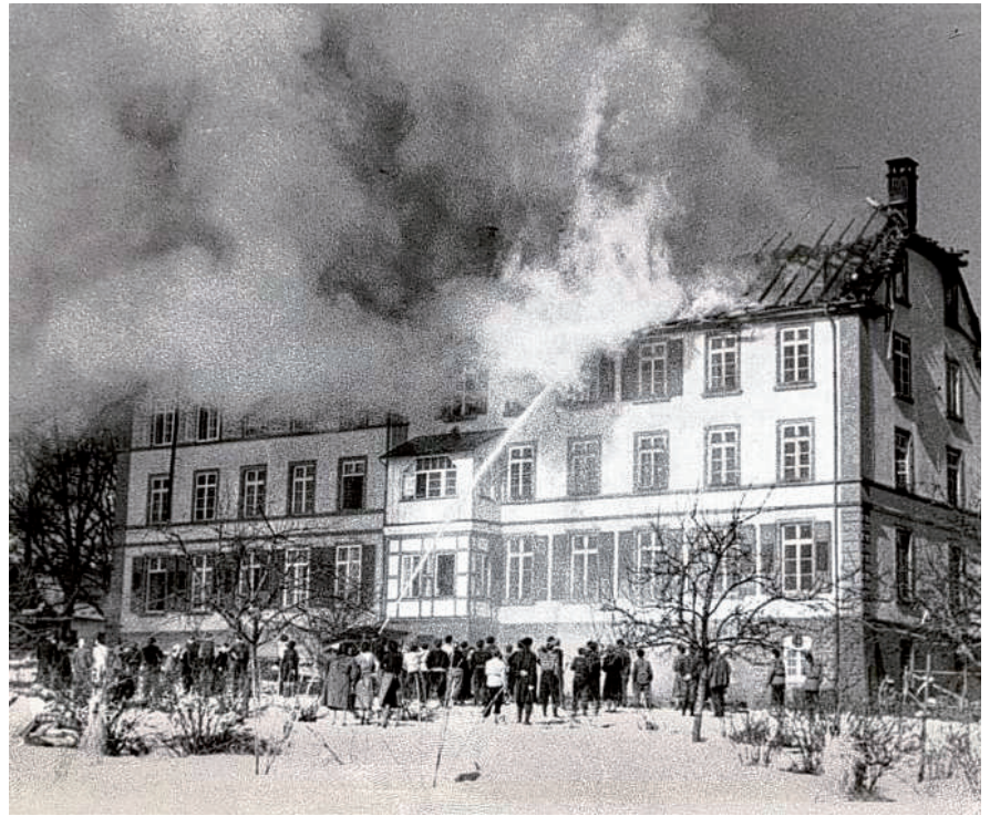
Die Schule brennt: Die Knabenanstalt wurde am 26. Februar 1953 beinahe vollständig zerstört. BILD: WALTER WETTSCHEN
