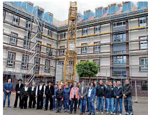
Handwerker, Planer und Mitarbeiter der Zinzendorfschulen feiern am Freitag Richtfest am Schulgebäude Haus Spangenberg. BILD: LOTHAR HERZOG
