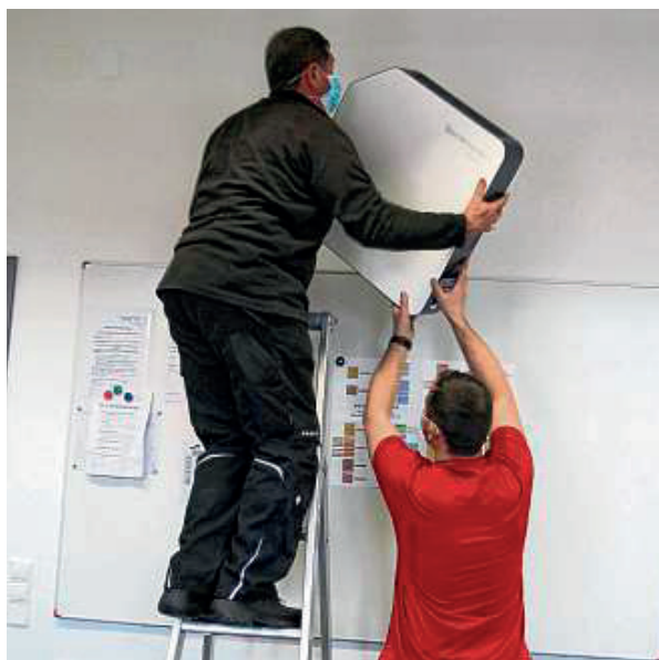
Die Hausmeister Stefan Sohmer (rechts) und Valerian Fangrath installieren die Luftreinigungsgeräte in den Klassenzimmern.
