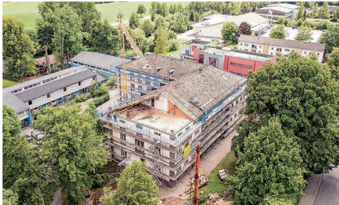
Der Dachstuhl des Hauses Spangenberg wird komplett abgetragen und durch einen neuen ersetzt. BILD: ZINZENDORFSCHULE
